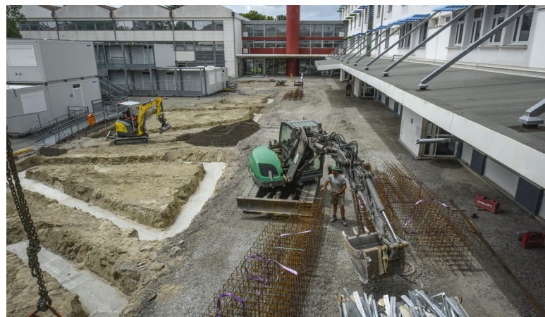
Travaux de restructuration au collège Ravel de Saint-Jean-de-Luz
