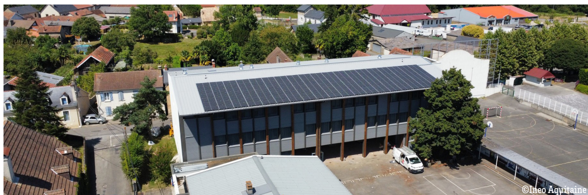
Travaux de restructuration énergétique du collège du Vic-Bilh à Lembeye
