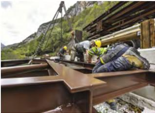
Début de la deuxième phase de travaux au défilé du Portalet: réalisation d'une passerelle métallique en encorbellement de la RN 134
