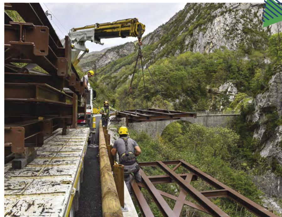
Deuxième phase du chantier du Portalet : pose des compléments de charpentes métalliques sur lesquelles sera posée la passerelle piétonne
