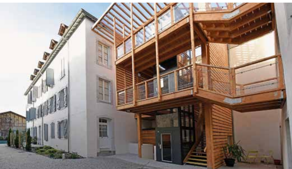
A Orthez, Etienne Brana et Arnaud Père-Laperne ont rénové l'immeuble de La Belle Hôtesse qui abrite désormais 20 appartements occupés par de jeunes actifs, des familles monoparentales et des retraités.
