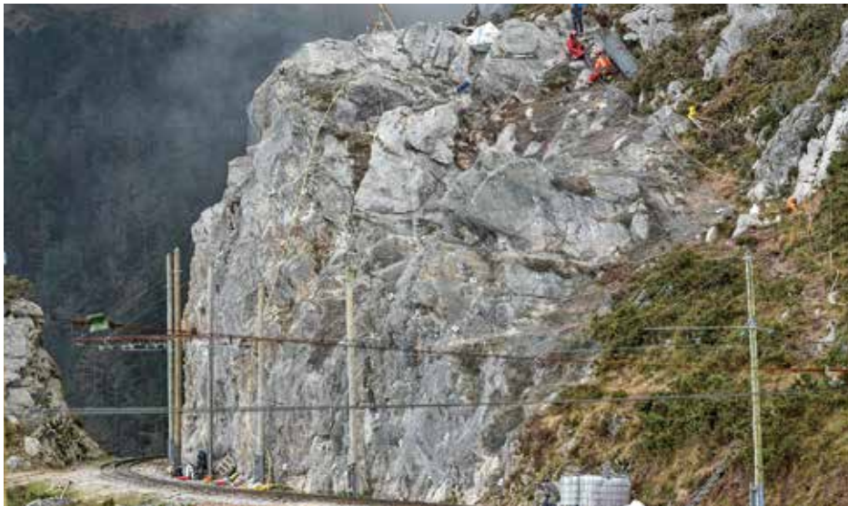
Le train touristique de la Rhune reste ouvert cette année du 16 avril au 4 septembre. La mise en service de la nouvelle voie est prévue pour l'été 2023.
