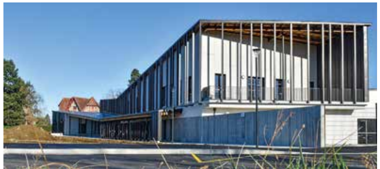
Décidée par le Département en 2016, la construction du nouveau collège de Pontacq porte la capacité d'accueil de l'établissement à 492 élèves.
