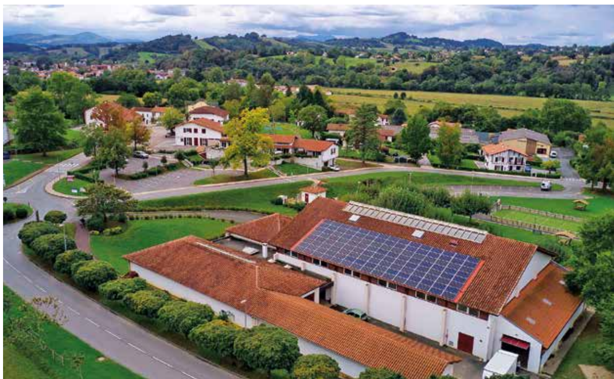
Les panneaux solaires installés sur la salle polyvalente d'Aicirits produisent 40 000 KW heures par an, soit l'équivalent de la consommation annuelle de 10 foyers.
