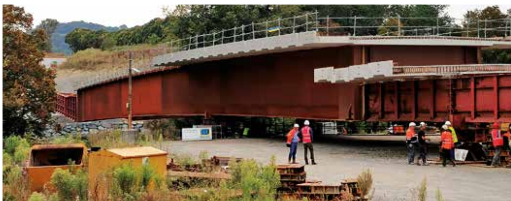
Le pont de Viellenave-de-Navarrenx, d'un seul tenant, a été poussé d'une rive à l'autre du gave d'Oloron.
