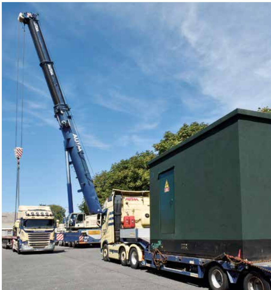
Lors de la pose du premier nœud de raccordement optique, le 3 septembre 2019 à Coarraze-Nay.
